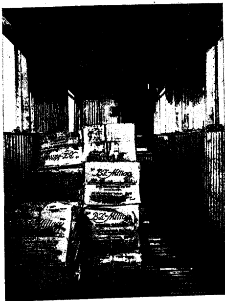
Blick in den Packraum eines Heinkel-Zeitungsflugzeuges
